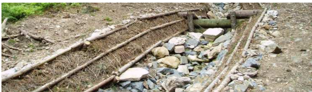
Obr. 36: Příklad realizace hrazení strže
