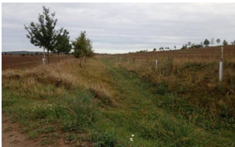
Obr. 26: Zasakovací a záchytný příkop s dřevinami na obou stranách, převzato od VÚV TGM, v.v.i.
