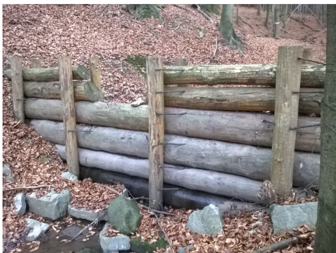
Obr. 39: Ukázka srubové přehrážky
