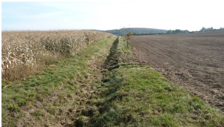
Obr. 25: Ukázka protierozního příkopu (bez hrázky a doprovodné výsadby)
