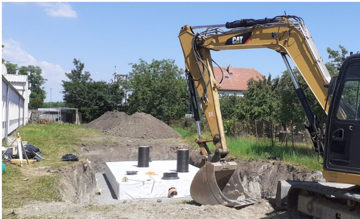
Obrázek 12: Akumulační nádrž na zchytávání dešťové vody ze střech MŠ Smetanova – průběh realizace, červenec 2023
