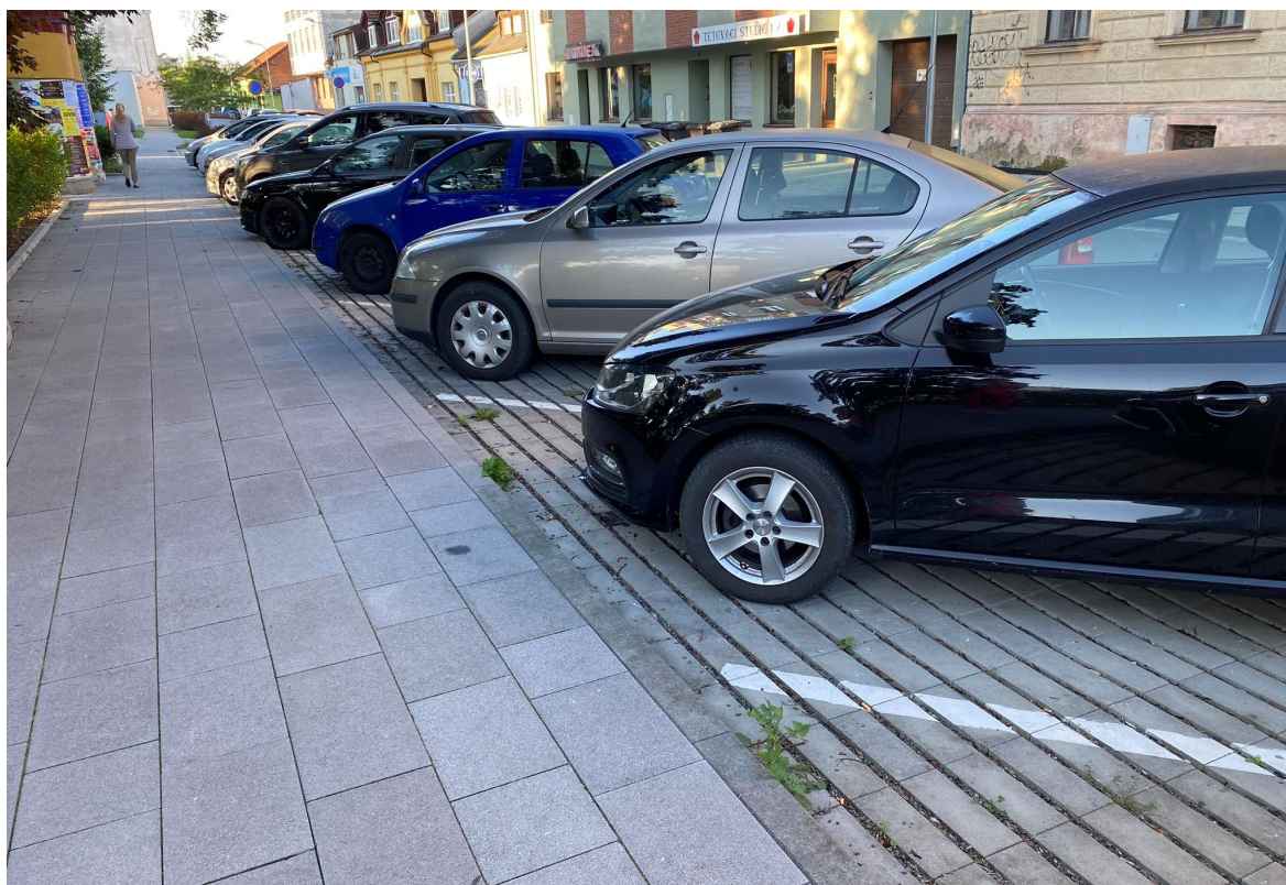
Obrázek 7: Polopropustný povrch na Floriánském náměstí
