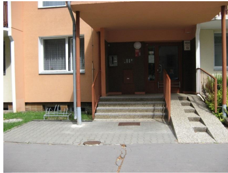
vstupy BD po rekonstrukci
