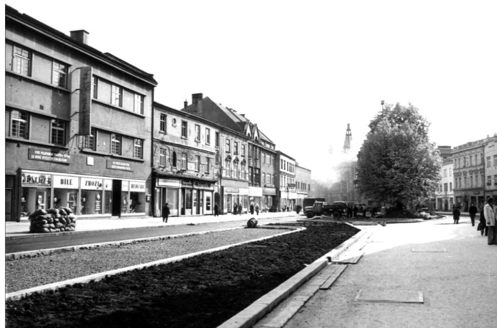
80. léta 20. století, výstavba parkovacích stání v severní části náměstí, pohled k J
