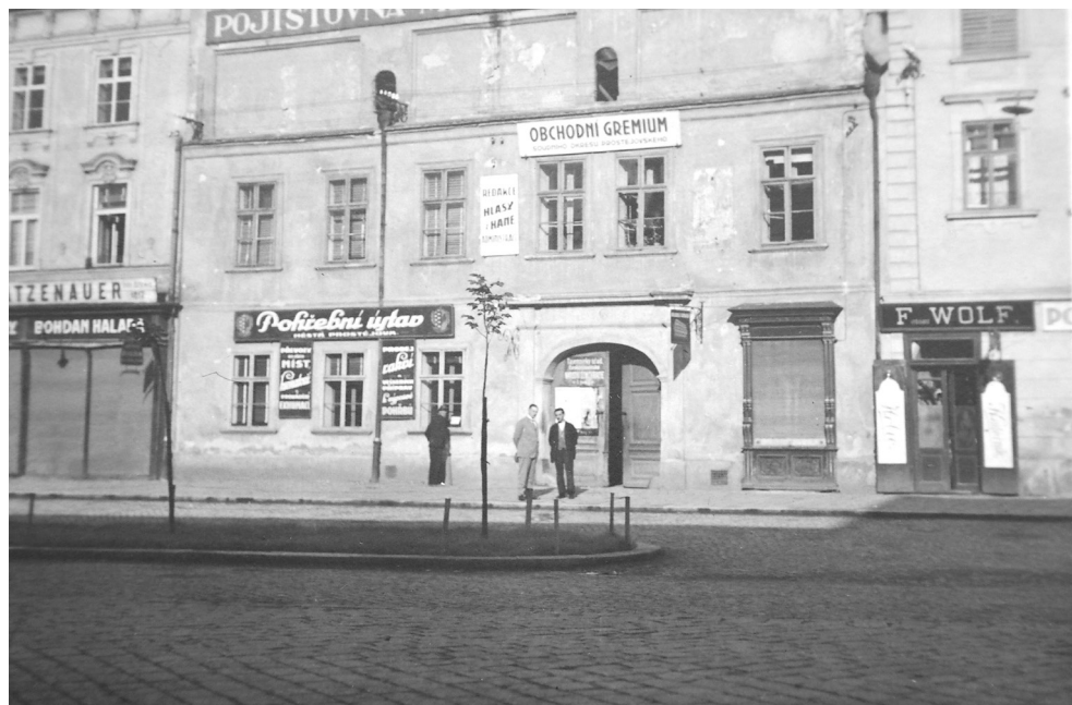
1925, dům zbouraný pro výstavbu Městské spořitelny s částí úpravy J prostoru náměstí
