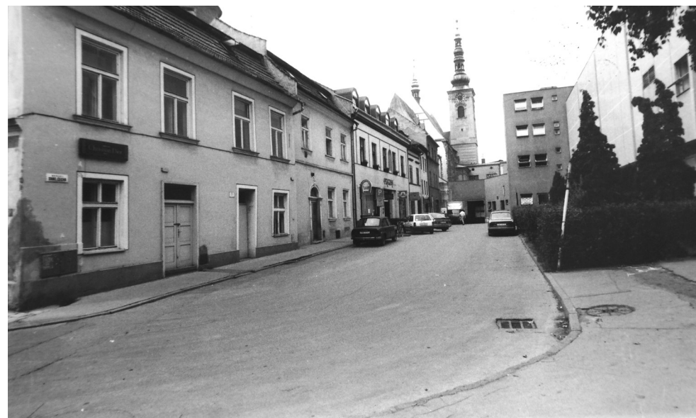
po 1973, vozovka i chodníky jsou opatřeny asfaltovým krytem
