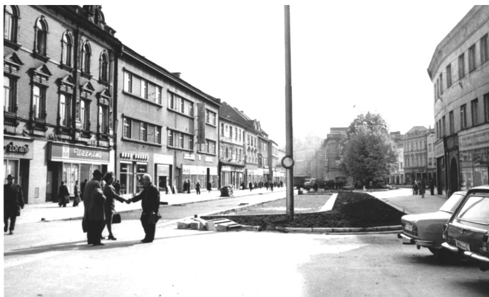
80. léta 20. století, výstavba parkovacích stání v severní části náměstí, pohled k J
