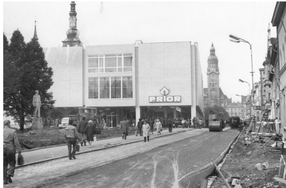
1973, pohled k Z po úpravě
