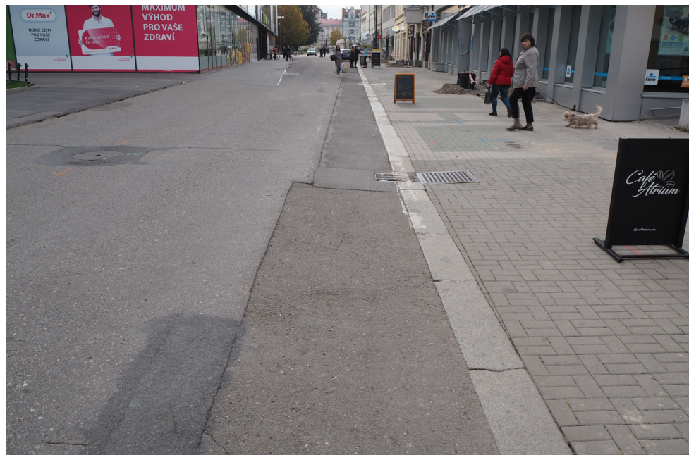
2021, současný stav, historické obrubníky zapuštěné v současné dlažbě, pohled k Z
