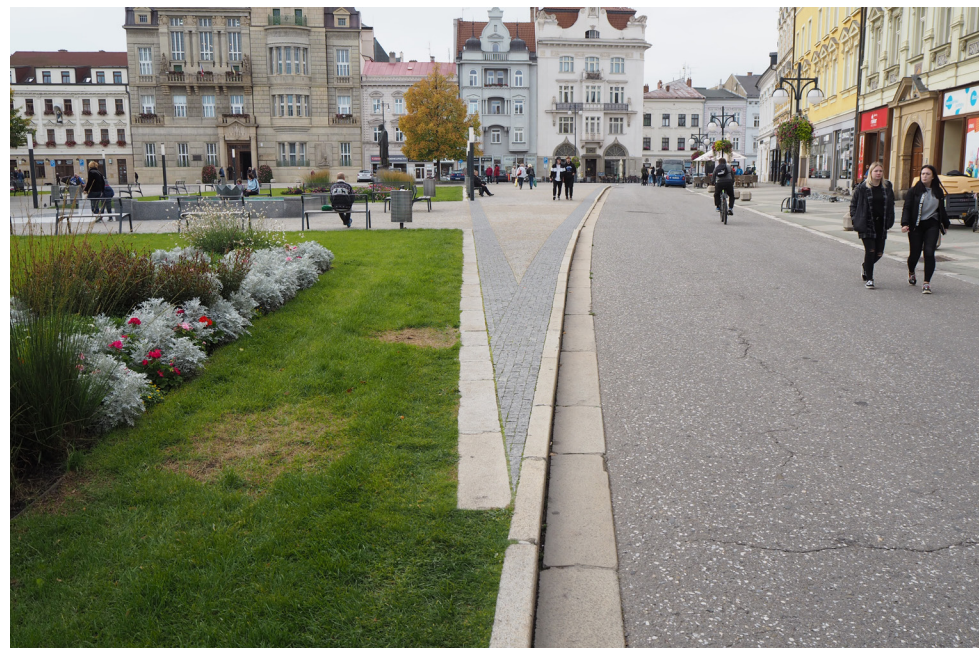
2021, současný stav, pohled k Z
