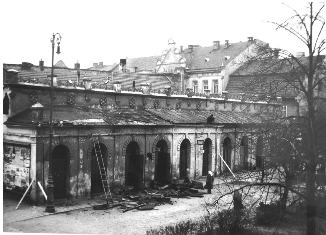
1951, demolice jatek, pohled k SZ
