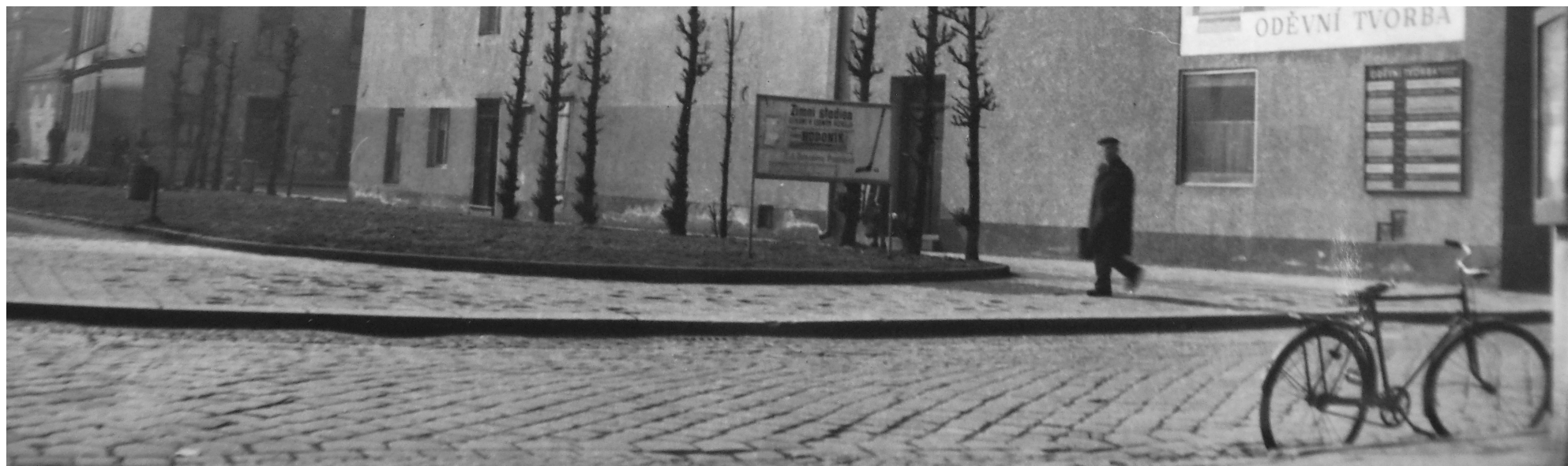
1969, detail vozovky a chodníku v severní části náměstí Sv. Čecha
