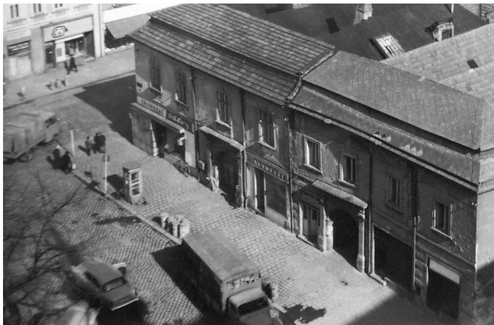
1969, dlažba východní části náměstí před domy určenými k demolici, pohled k SV
