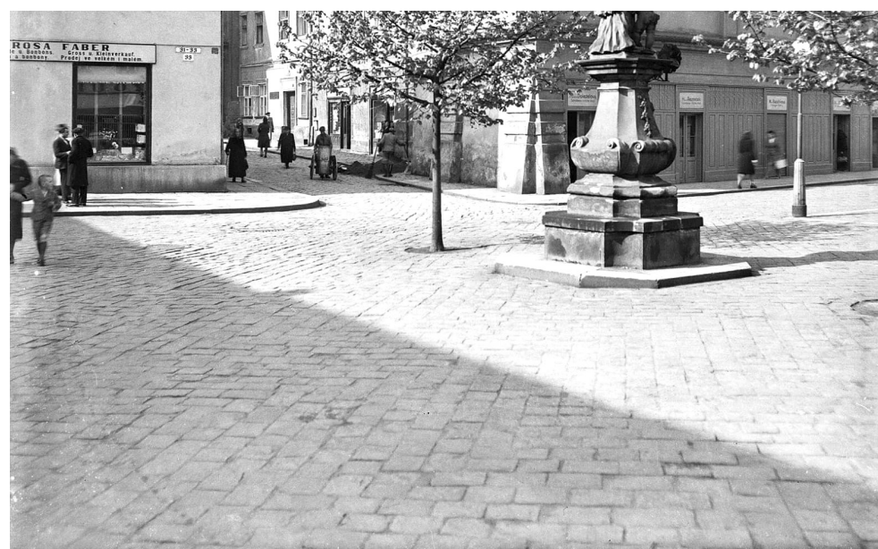
30. léta 20. století, detail zádlažby ve východní části náměstí, pohled k J
