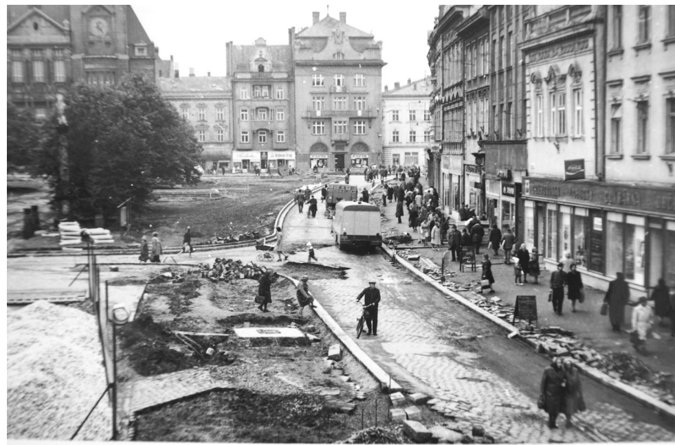
1975, rekonstrukce náměstí, pohled k Z
