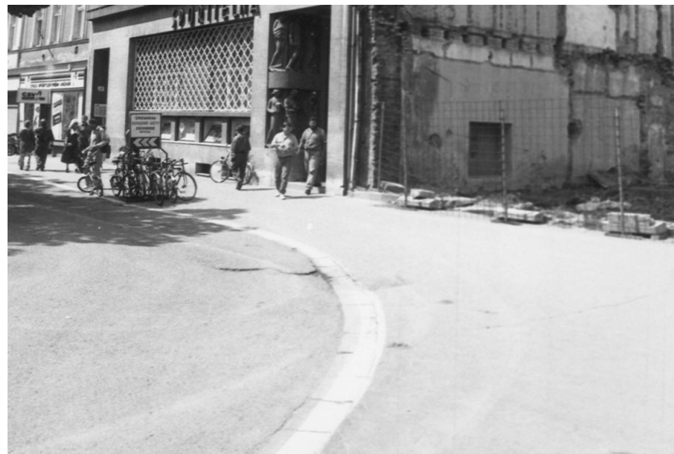
1995, komunikace před spořitelnou, pohled k J
