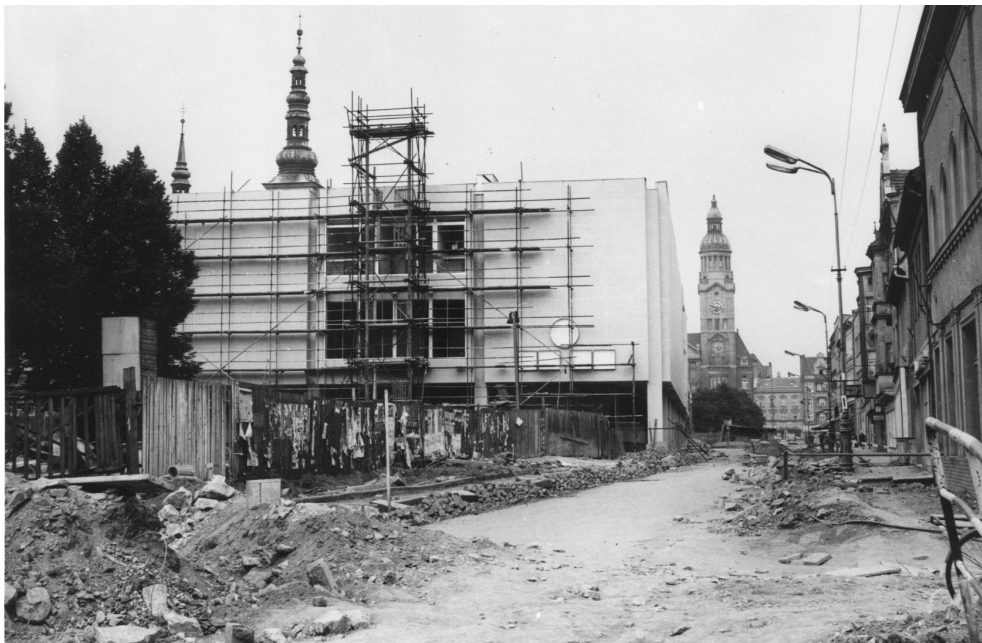
cca 1972, pohled k Z během výstavby OD a úpravy okolí
