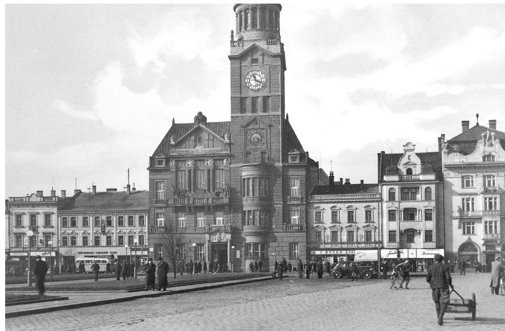
1933, detail vozovky, pohled k Z
