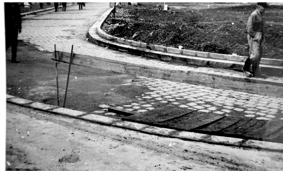
1975, rekonstrukce náměstí, detail obrubníků a dlažby vozovky
