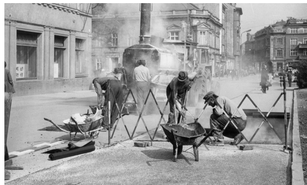
1973, asfaltování chodníku v S části náměstí, pohled k V
